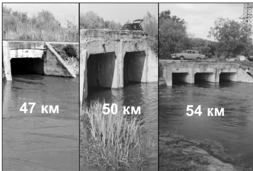
Рис. 2 Водотоки на автотрассе Маяки-Паланка, оставшиеся после ее строительства
