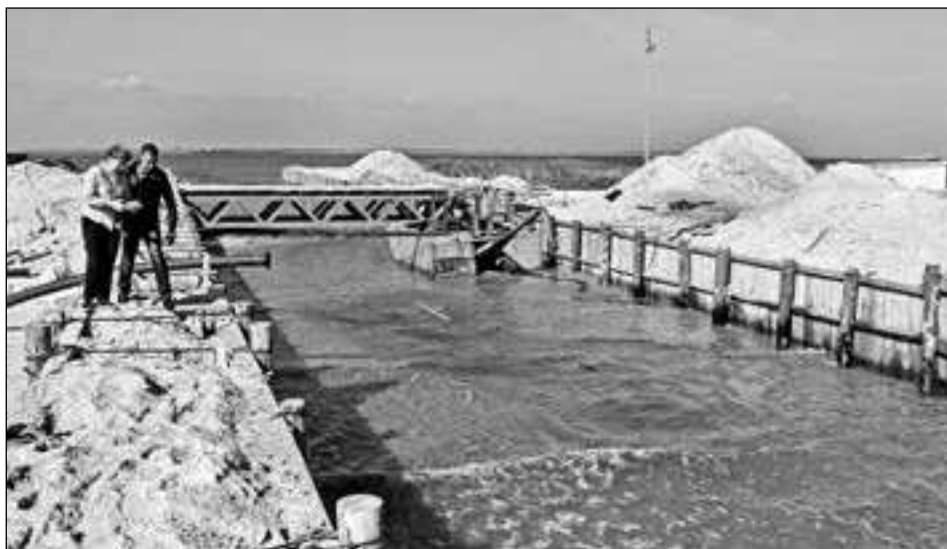
Рис. 5.6. Будівництво каналу на 2 км піщаного пересипу у 2015 р. (вид зі сторони лиману Бурнас)
