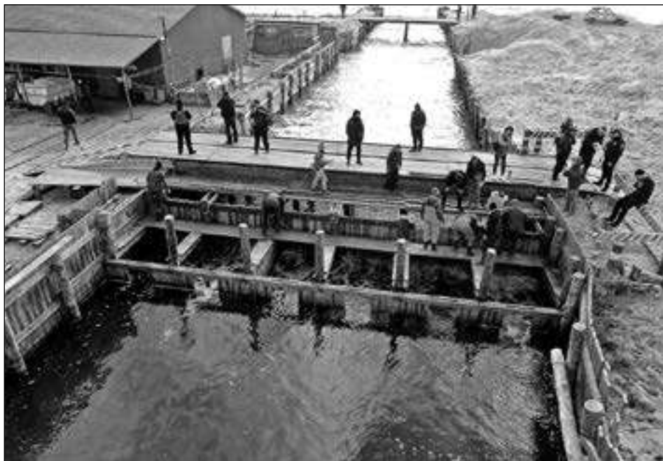
Рис. 5.25. Під час демонтажу гардів ТОВ «ІМА»
