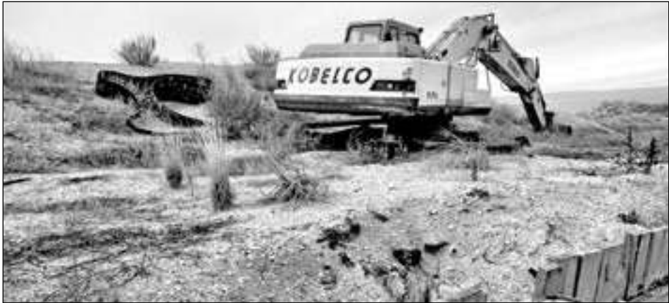
Рис.5.30. Екскаватор ТОВ «ІМА» непридатний для проведення робіт
