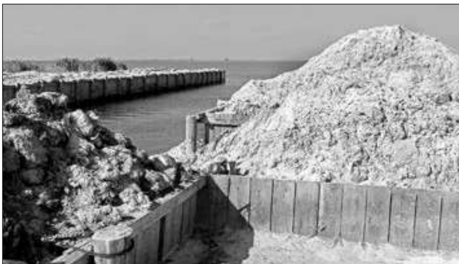
Рис. 5.4. Збудований канал на 2 км піщаного пересипу
