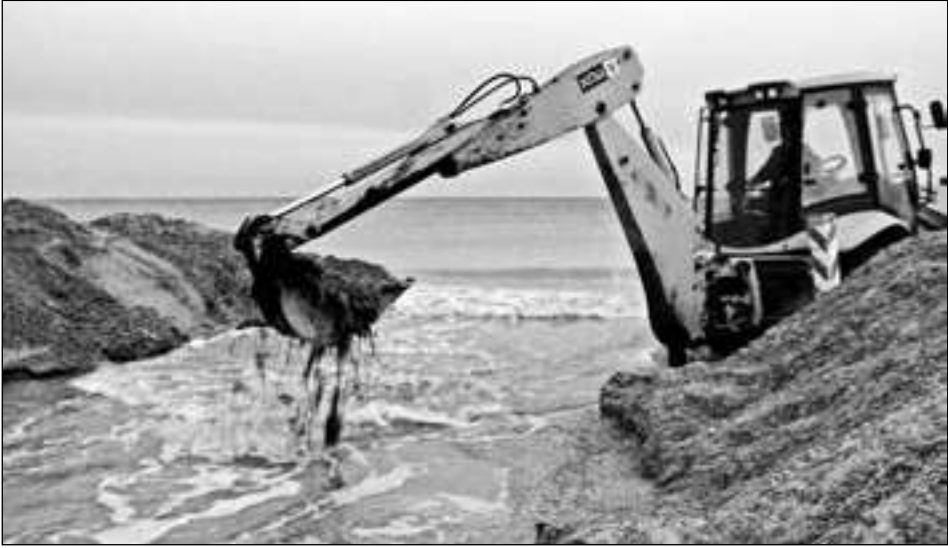
Рис. 5.53. Відновлення роботи протоки на 23 км піщаного пересипу
