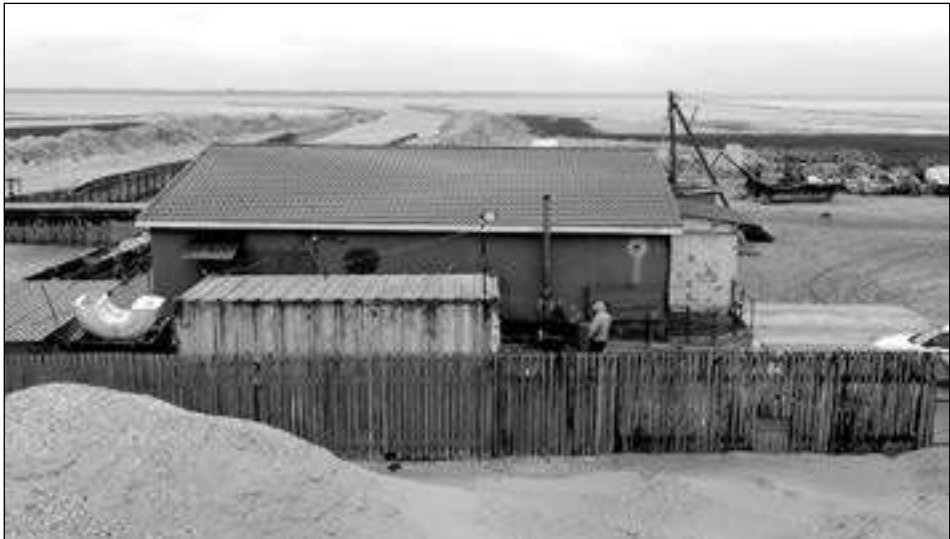
Рис. 5.8. Канал та споруди на 2 км пересипу, обнесені парканом
