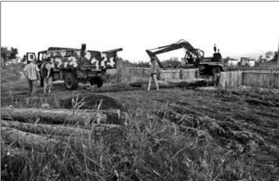
Рис.5.3. Початок будівництва каналу на 2 км піщаного пересипу (фото Ірини Вихристюк)
