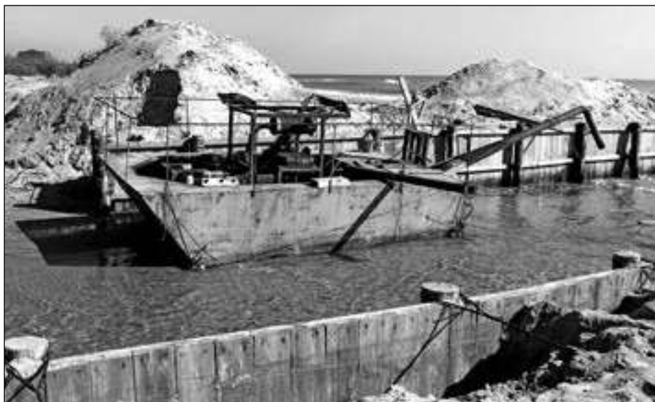
Рис. 5.5. Нове будівництво каналу на 2 км піщаного пересипу
