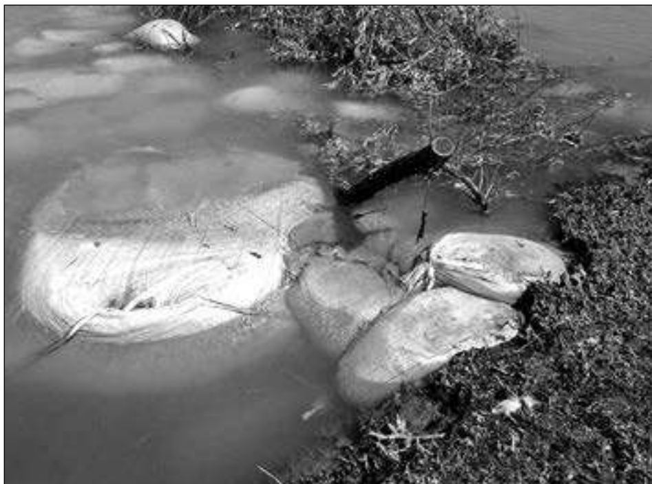
Рис. 5.36. Мішки з піском перекривають прорву на 24 км піщаного пересипу (Фото І.Вихристюк)
