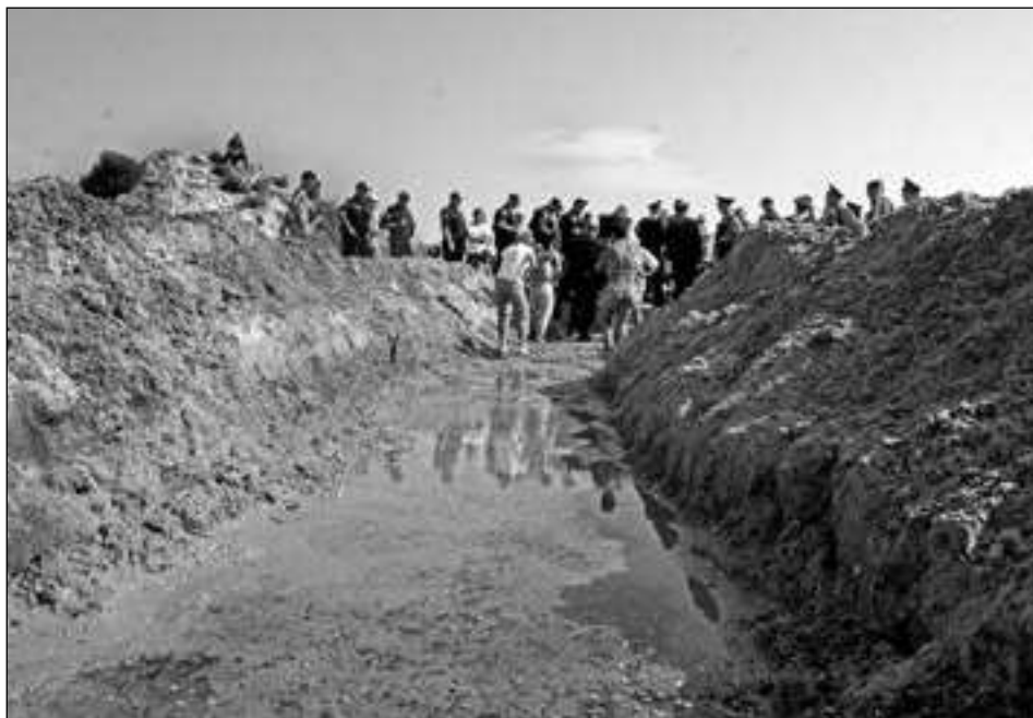
Рис.5.38. Під час формування прорви вручну на піщаному пересипу
